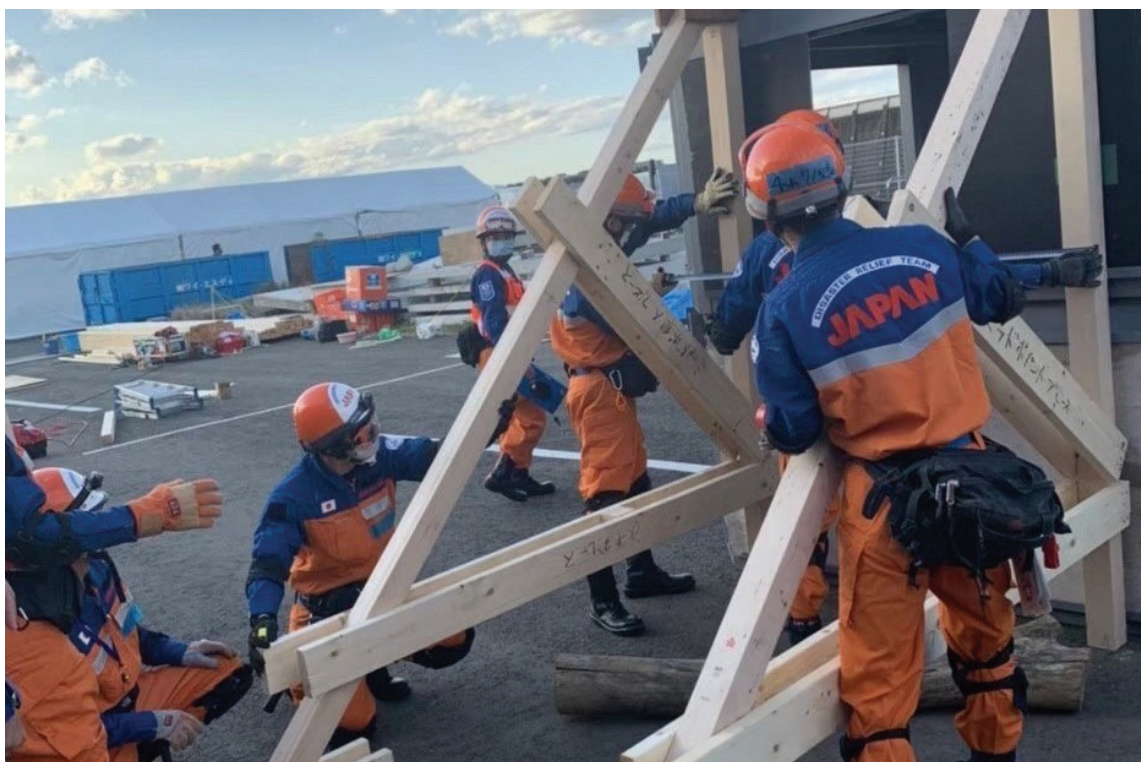
令和2年度国際緊急援助隊救助チーム技術訓練 (令和2年11月 東京都立川市)
